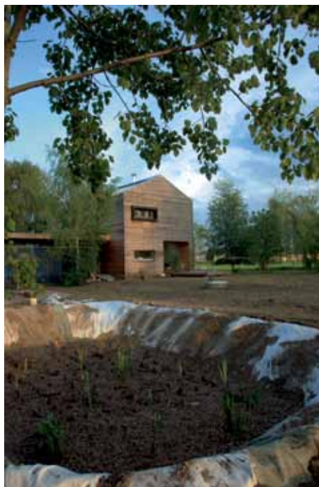
Koreňová čistička odpadových vôd tesne po osadení rastlín (foto: Kořenovky.cz)
